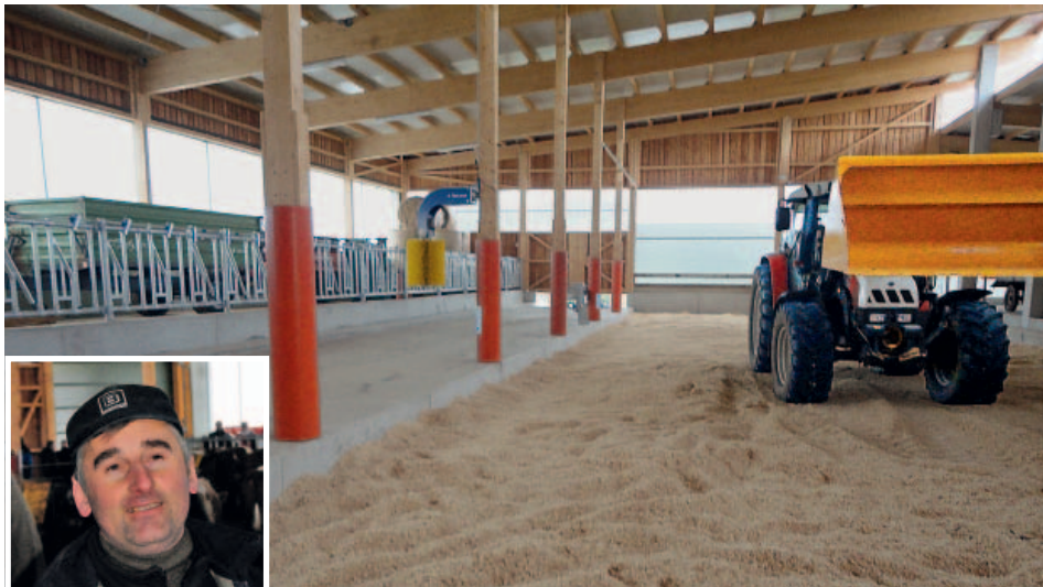
Auf dem Betrieb von Vorname Zeilinger kann die Lüftung mit Rollvorhängen gesteuert werden. Oben im Dach ist eine grosse Lüftungsöffnung vorhanden.
