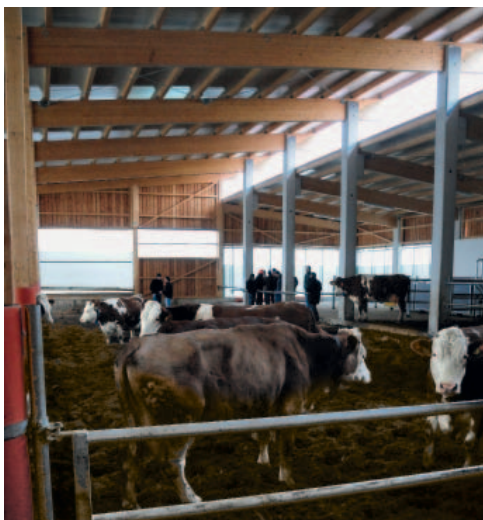
Auf dem Betrieb von Vorname Zeilinger kann die Lüftung mit Rollvorhängen gesteuert werden. Oben im Dach ist eine grosse Lüftungsöffnung vorhanden.
